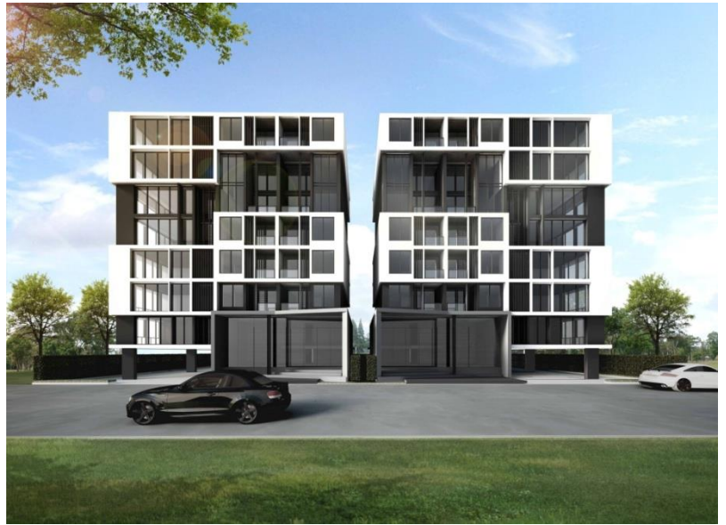
โครงการ Rising Place A&B
